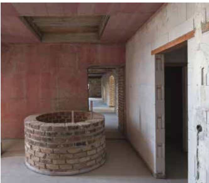
Die Räume des ehemaligen Kartoffelkellers wurden durch Wände aus Ytong-Porenbeton neu aufgeteilt.
