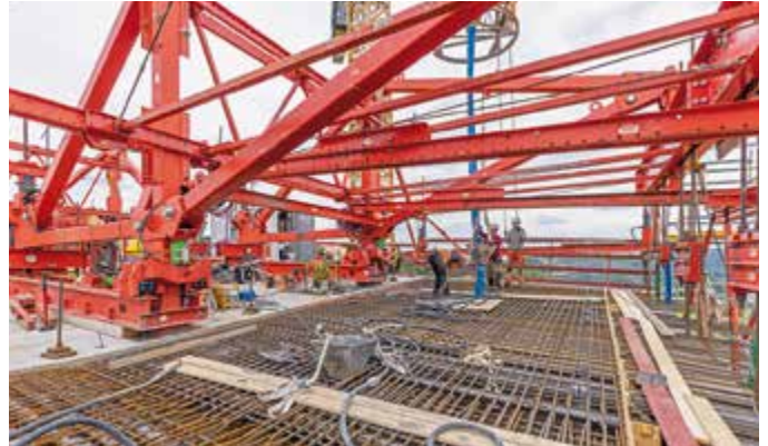
Der gevoutete Spanbeton-Hohlkasten wird in 5,75 m langen Betonierabschnitten im Freivorbau monolithisch hergestellt. Bilder: Peri
