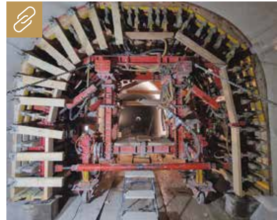
Die GM6 wurde auf dem Tunnelwagen von Rubrika und teilweise auch in der Tunnelschalung von Peri verwendet. Bilder: Alkus
