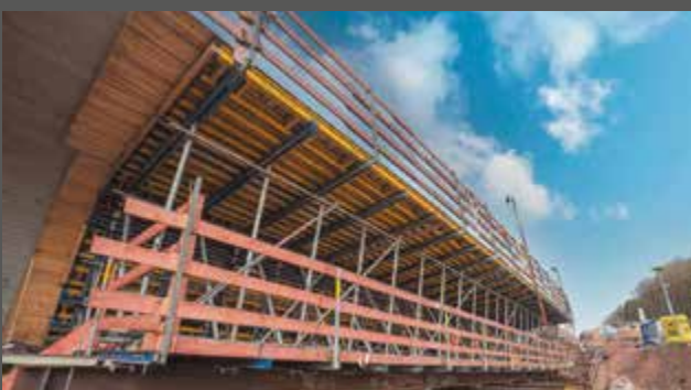
In diesem Taktkeller steckt viel Know-how aus vorangegangenen Projekten im Taktschiebeverfahren.
