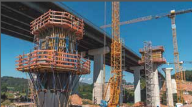
Die Brückenpfeiler in verschiedenen Stadien: links mit Pfeilerkopfschalung, in der Mitte mit Pfeilerschalung, rechts ausgeschalt.
