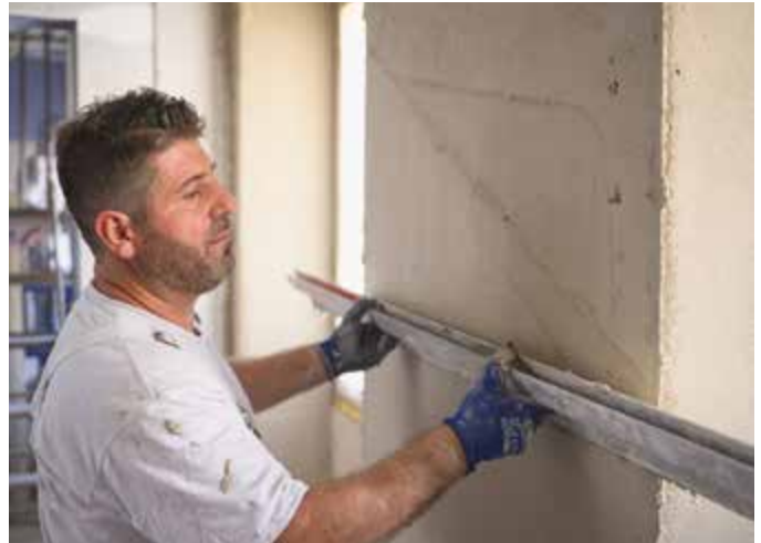
Die Ecosphere-Spritzdämmung eignet sich ideal zum Abziehen und ergibt nach dem Glätten eine optimale Oberfläche. Bilder: Daniel Peter/Maxit
