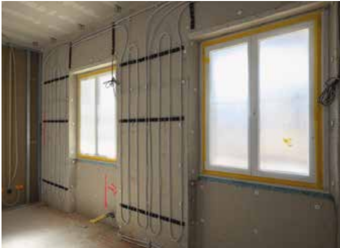
Auf der Spritzdämmung sorgt ein zusätzlich aufgebrachter Putzträger für einen sicheren Kraftschluss des anschließenden Kalkputzes.
