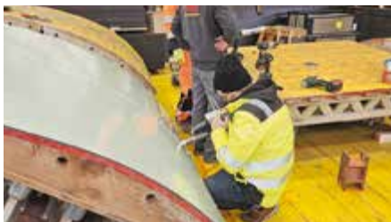
Verschweißen der alkus GM6 Schalungsplatten auf der Peri-Stollenschalung.
