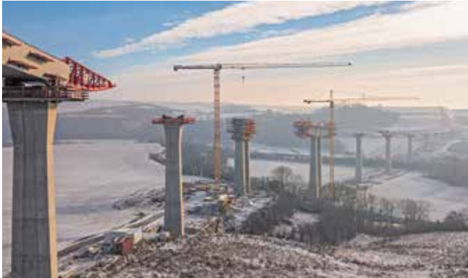
Mittels Takttschiebeverfahren nähern sich die Rampenbereiche der Brückenmitte, dessen Überbau im Freivorbauverfahren hergestellt wird.
