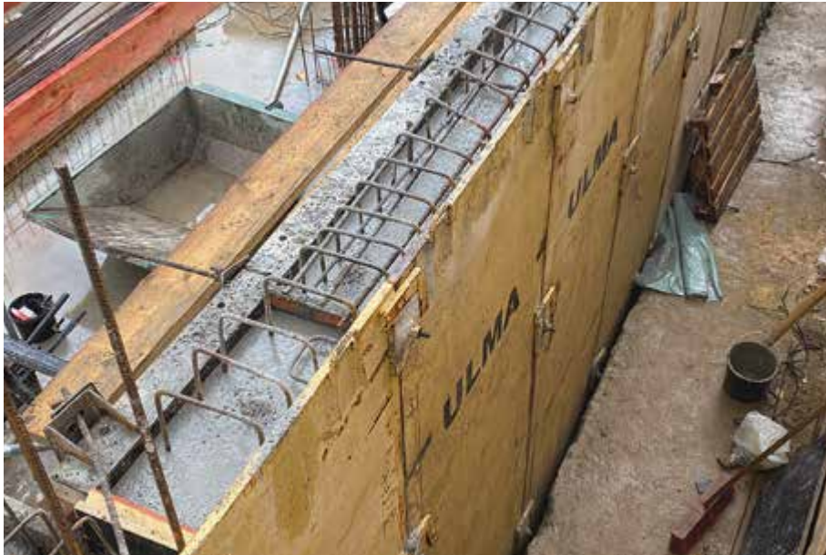
Nur eine handbreite Platz steht als Arbeitsraum zwischen der Baugrube und der Außenkante der Wand zur Verfügung. Mit einer Verbauschalung aus Stahlblech hat Ulma dafür eine ideale Lösung parat. Bild: Ulma
